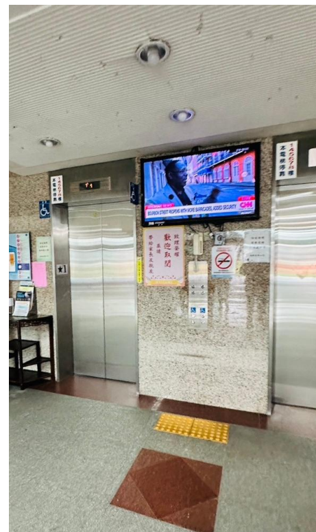
升降機引導標誌
