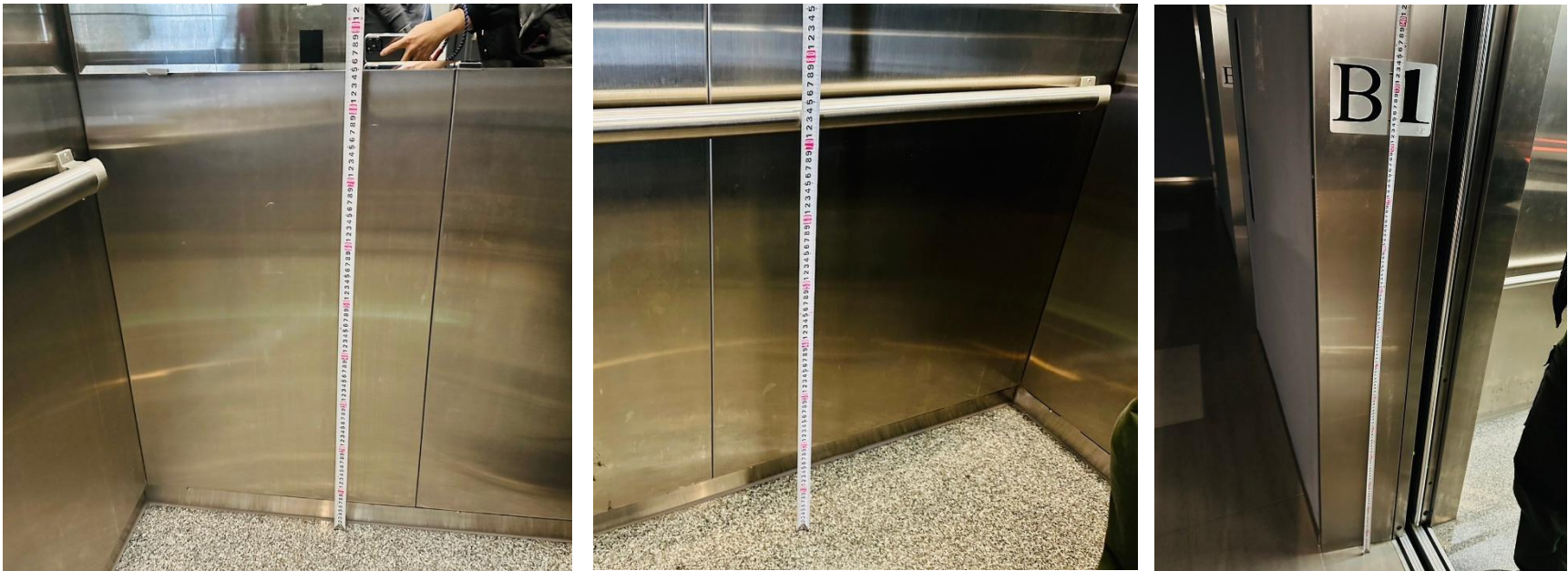
後視鏡高度(地面起≤85cm)： 85cm ( 符合規定) 車廂扶手高度(75~85cm)： 75cm ( 符合規定)
