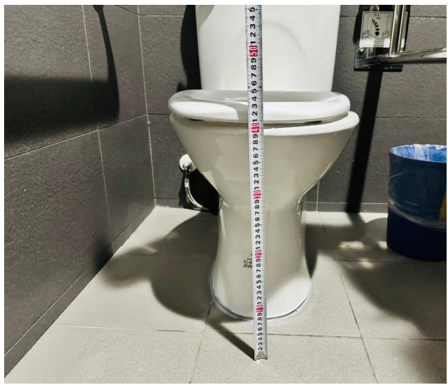
馬桶扶手高度離座墊高度(27cm)：27cm（符合規定）
