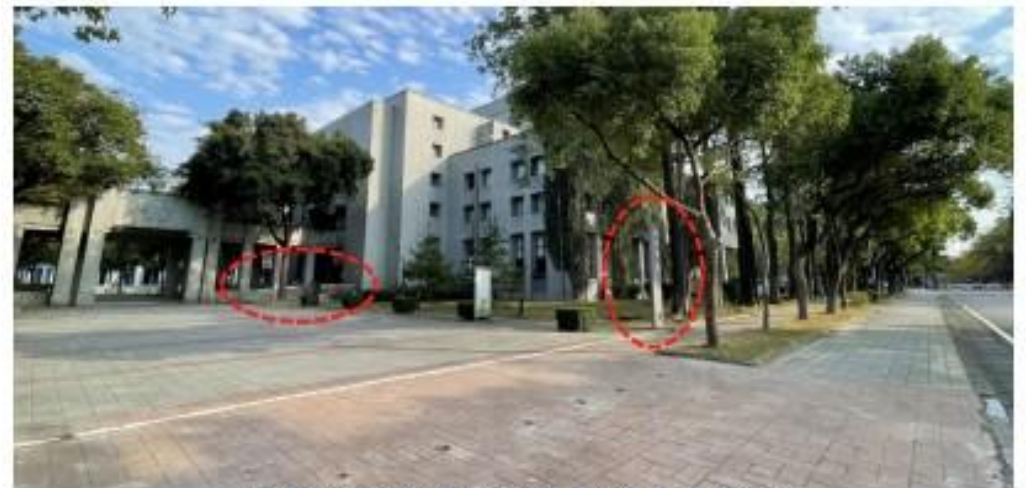
無障礙坡道(左)及指示牌(右)
