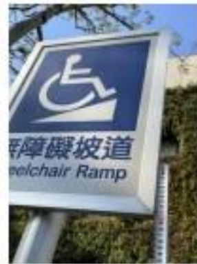
標示牌下緣 離地 90 公分
