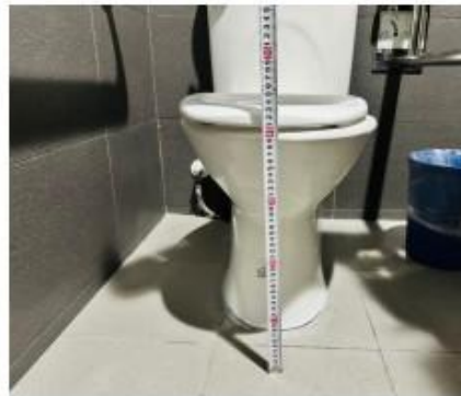
一 馬桶扶手高度離座墊高度(27cm)：27cm (符合規定)
