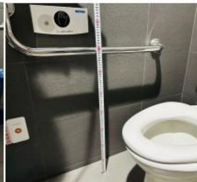
一 馬桶扶手高度離座墊高度(27cm)：27cm (符合規定)
