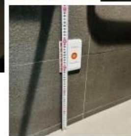
一 求助鈴(上組離座墊高度(60cm)(下組離地高度(15~25cm))
